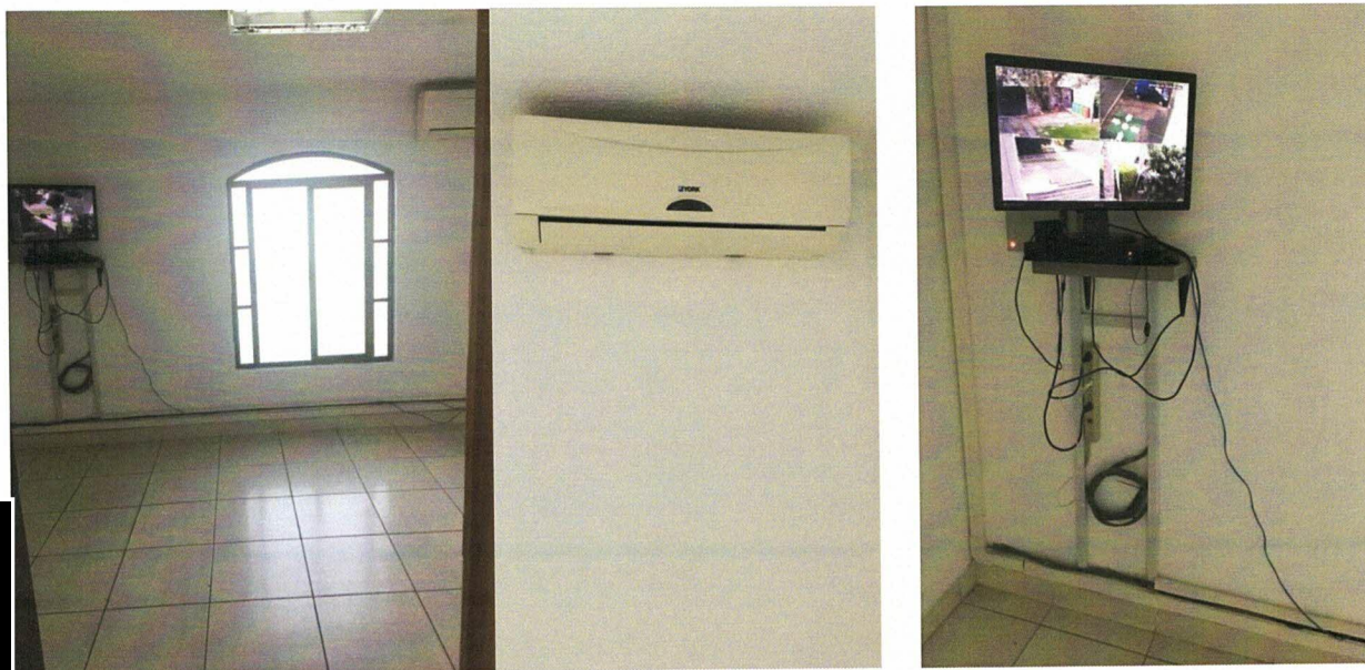
IMAGEN 20.-OFICINA DE VIDEOVIGILANCIA Y MONITOREO.- SISTEMA DE VIDEOVIGILANCIA EL CUAL CUENTA CON UN MONITOR DE 24", DISCO DURO PARA ALMACENAMIENTO DE VIDEOS CON SUS ACCESORIOS, QUE OPERA CON 4 CAMARAS LAS CUALES TAMBIÉN SE RECIBEN COMO TE INTEGRAL DE ÉSTA OFICINA.
