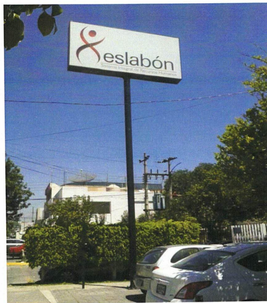
IMAGEN 16.-ANUNCIO ESTRUCTURAL LUMINOSO A DOS CARAS, EL CUAL SE ENCUENTRA POR AV. ARCOS, QUE ES EL QUE SE DESCRIBEN EN EL INCISO A) DEL PUNTO NÚMERO I UNO ROMANO, DE LA SECCIÓN CORRESPONDEINTE A LAS DECLARACIONES DEL ARRENDADOR DESCRITAS EN EL CONTRATO . EL MISMO TIENE UNA ALTURA DE 8.5 METROS, Y LA ESTRUCTURA EN EL CUAL SE PUEDE PONER UN ESPECTACULAR POR AMBAS CARAS DE 4.00 METROS DE LARGO POR 2.00 DE ALTO, EL MISMO SE ENCUENTRA PINTADO EN NEGRO, CON EL DESGASTE PROPIO DE LAS INCLEMENCIAS DEL TIEMPO, CABE SEÑALAR QUE ÉSTE ANUNCIO ES MATERIA DE ARRENDAMIENTO PERO SE DESCRIBE CON LA FINALIDAD DE DEJAR CONSTANCIA DE SU EXISTENCIA, TODO LO RELATIVO A ESTA ESTRUCTURA EL ARRENDATARIO QUEDA LIBRE DE CUALQUIER RESPONSABILIDAD, POR DAÑOS QUE SE LE GENERE O PROVOQUE A TERCEROS.
