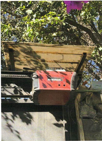
IMAGEN 1.1.- SEGUNDO ACCESO POR CALLE LA LUNA , CON MURO DE PIEDRA Y CON PORTÓN ELÉCTRICO CON MOTOR FUNCIONANDO, EL CUAL CUENTA CON SU CONTROL REMOTO DE IGUAL MANERA CON FUNCIONAMIENTO, CON PINTURA DESGASTADA.
