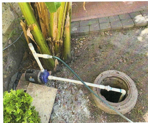
IMAGEN 25.- TAMBOS PARA BASURA Y BOMBA HIDRÁULICA.- EL INMUEBLE MATERIA DE ARRENDAMIENTO CUENTA CON UNA MOTOBOMBA DE 1 HP WEG, CON INSTALACIÓN COMPLETA Y SE PERCIBE EN BUEN ESTADO, ASÍ MISMO EN EL JARDÍN SE TIENE PARA EL SERVICIO DE RECOLECCIÓN DE BASURA 4 TAMBOS DE 250 LITROS MISMOS QUE SE APRECIAN EN LAS IMÁGENES, LA SISTERNA CON UN ORIFICIO PEQUEÑO, QUE NO DEJA PERCIBIR SI EL ALJIBE SE ENCUENTRA LIMPIO O SUCIO, ADEMÁS SE RESALTA QUE NO TIENE TAPA DE NINGUNA ESPECIE.
