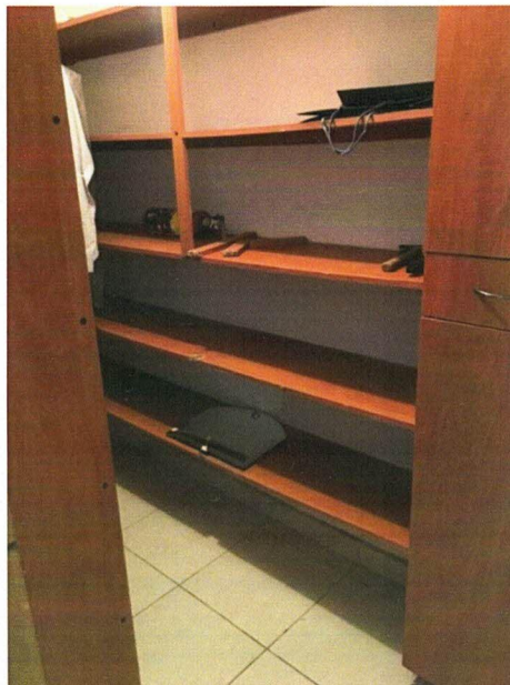
IMAGEN 19.-OFICINA DE ARCHIVO SITUADO FRENTE A EL CUARTO DE SISTEMAS Y VIDEOVIGILANCIA CON MUEBLES EMPOTRADOS SIN LAQUEADO RESCIENTE. LIMPIOS Y EN BUEN ESTADO, CON SU DESGASTE NATURAL.
